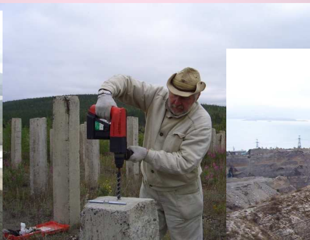
Магаданская область. Установка репера
