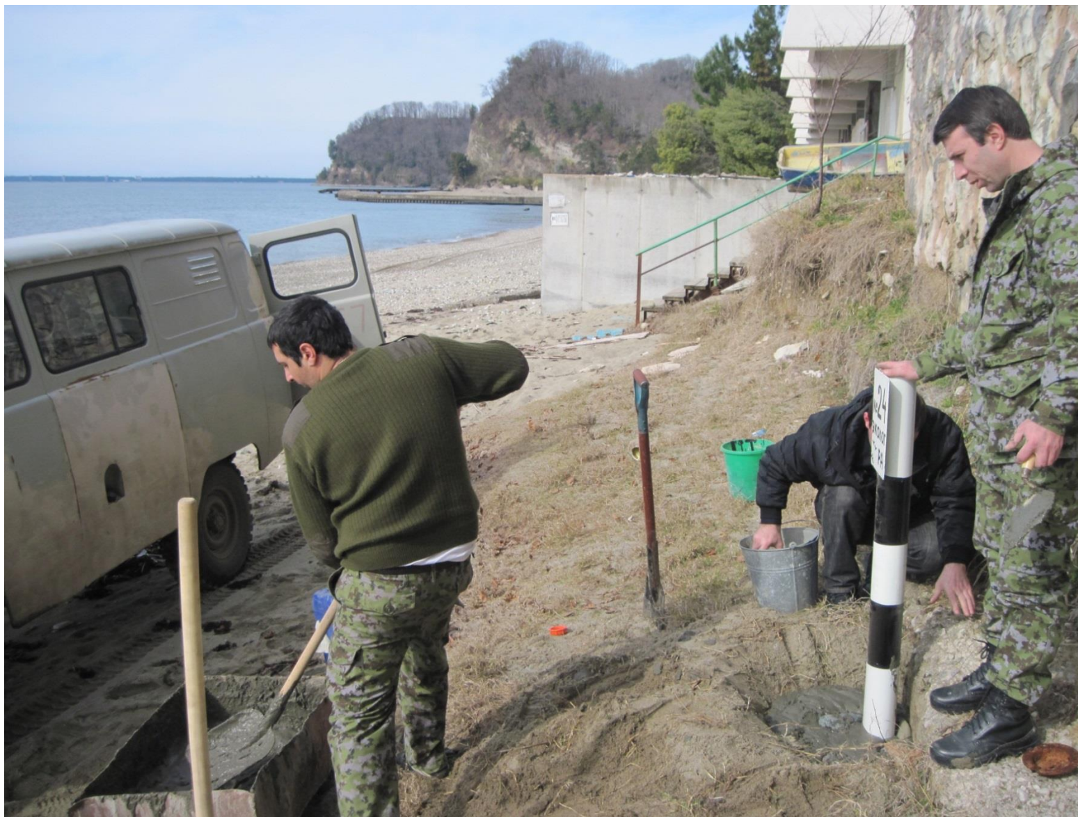
Рис 16. Установка репера на пляжной зоне санатория «Мюссера»
