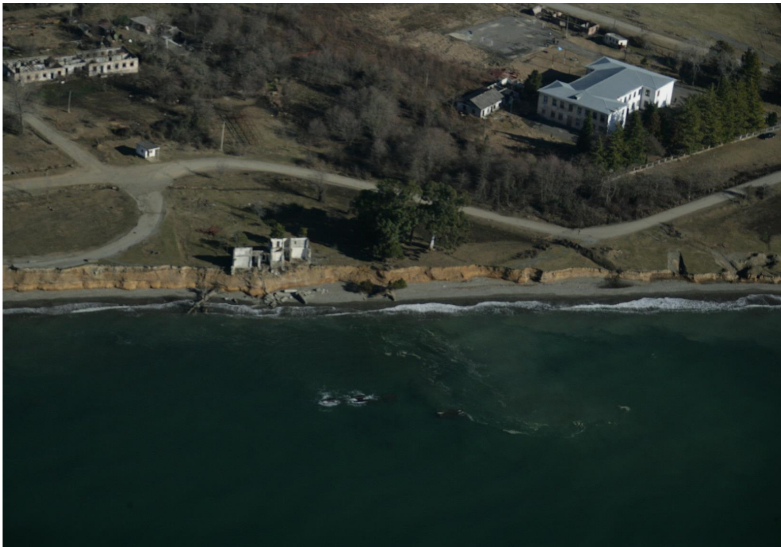
Рис 33. Разрушение строений и асфальтированной дороги восточнее порта укрытия.
