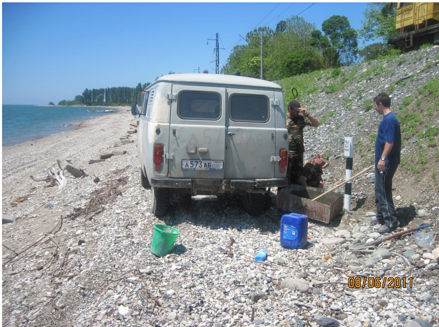
Рис 19. Установка репера в зоне активного размыва берега под ж\д полотном после отсыпки искусственного пляжа.
