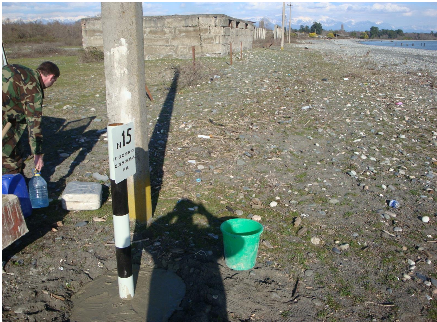
Рис 29. Установка репера на одном из участков Кодорского дельтового выступа
