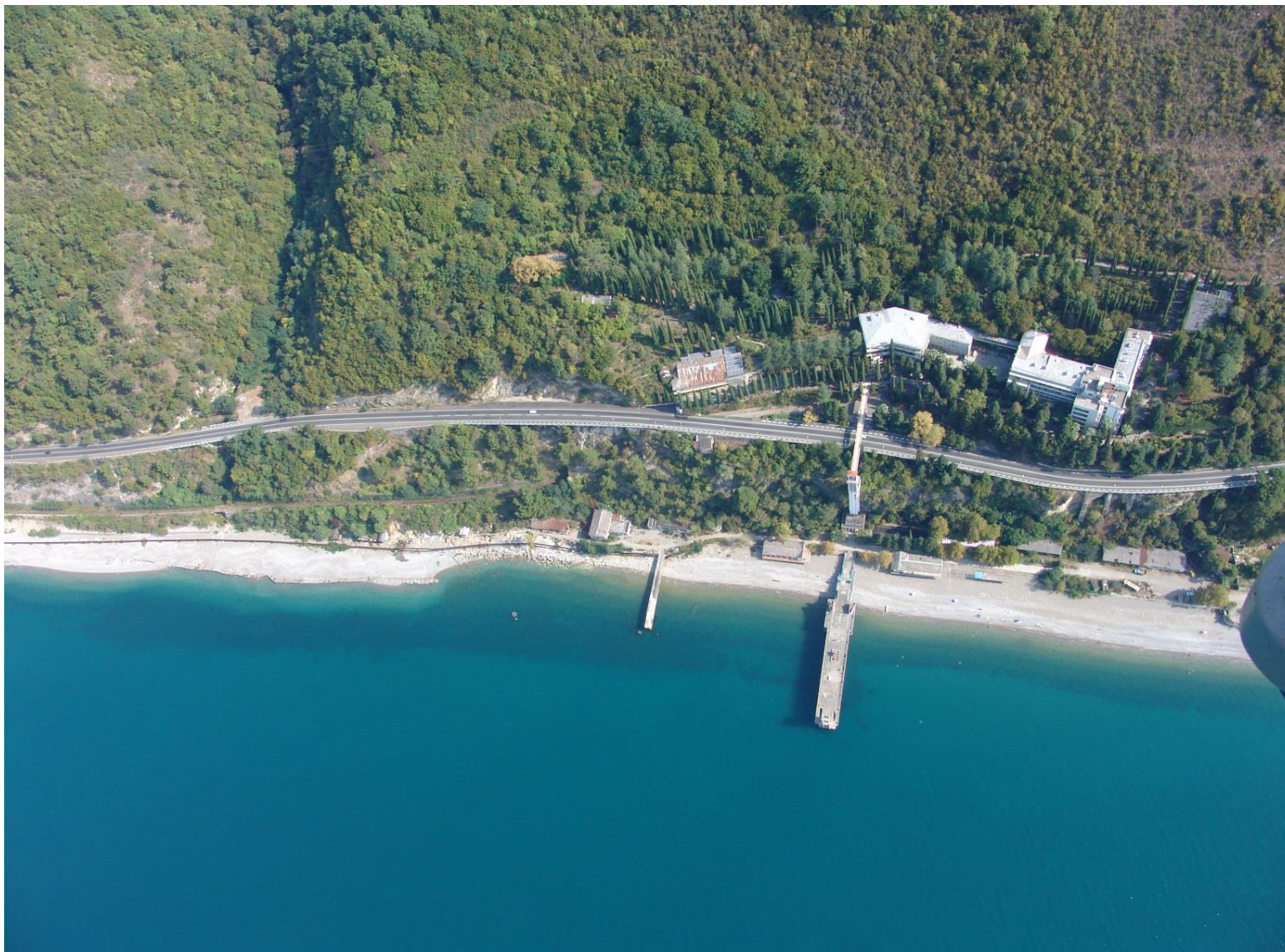
Рис 6. Магистральный водовод, в непосредственной близости от уреза воды
