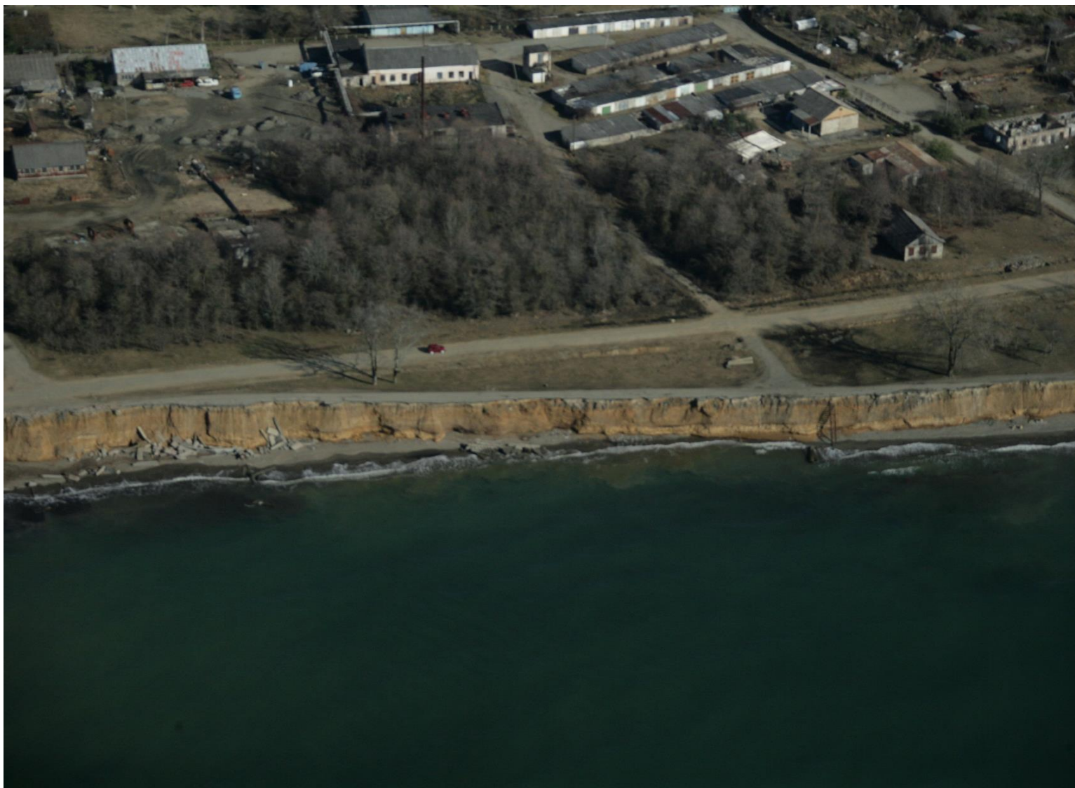
Рис 32. Абразия коренного берега в результате строительства порта укрытия
