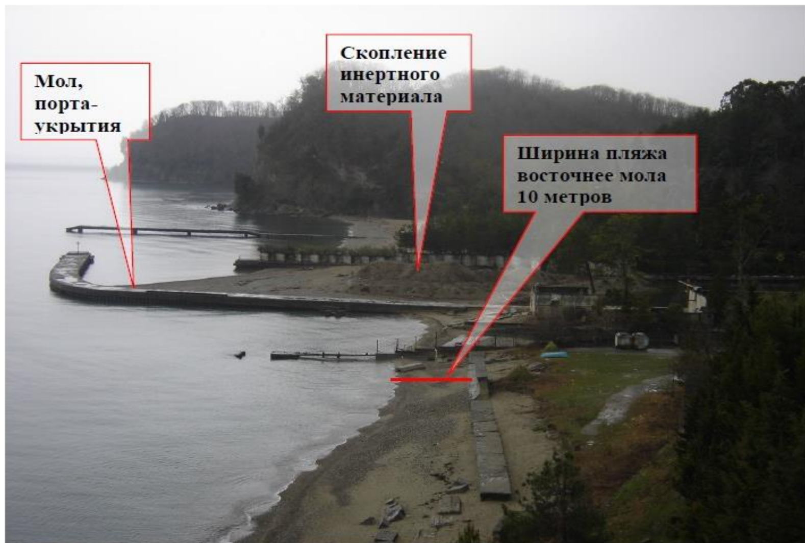
Рис 15. Мол, вызывающий явления заполнения входящего угла
