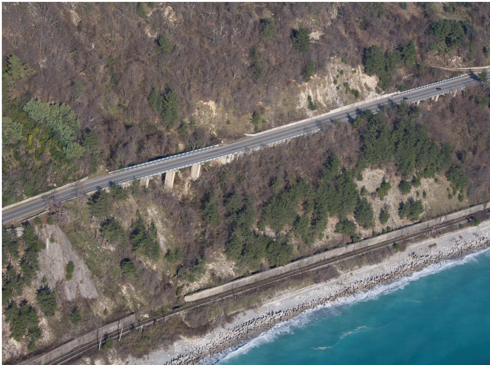
Рис 5. Берег, укрепленный тетраподами и бетонными кубами
